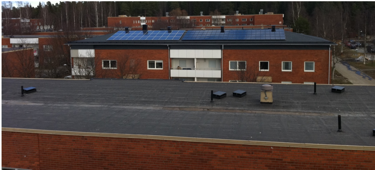
Figur 3. Exempel där ett platt tak byggts på med ett nytt valmat tak och där det sedan monterats solceller, i Ålidhem, Umeå. (Foto: Solkompaniet)
