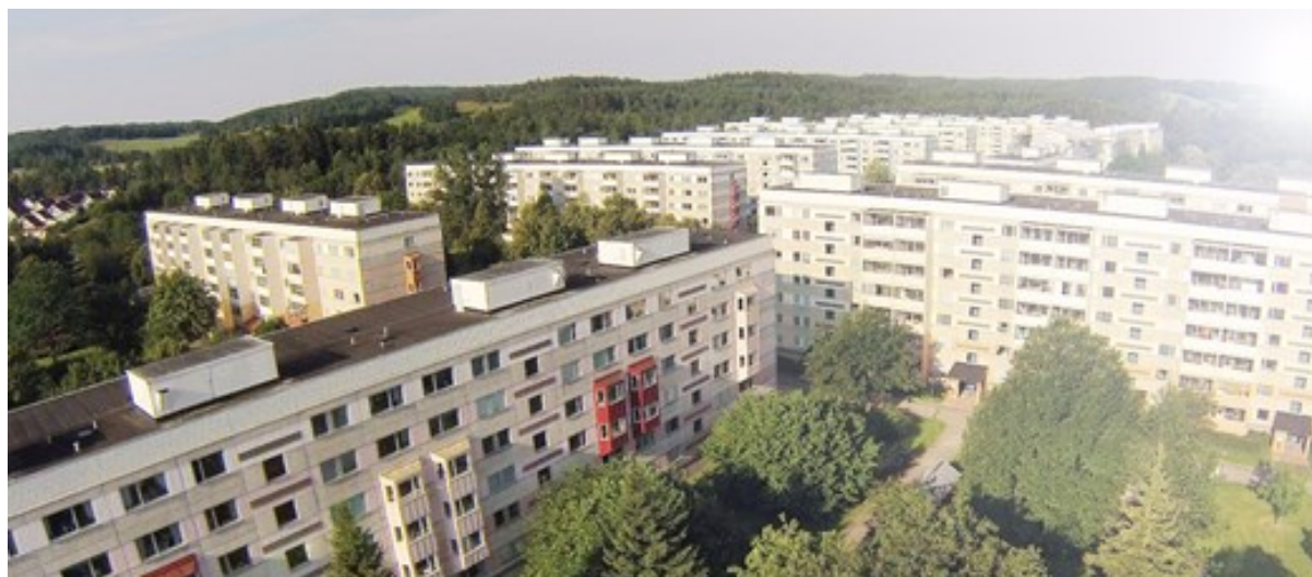
Figur 5. Exempel på byggnader med platta tak och befintliga fläktrum, i Råslätt, Jönköping. (Foto: Vätterhem)
